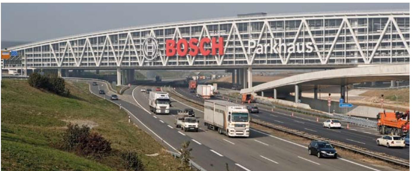
Insgesamt 105 Millionen Euro investierte die FSG in die Parkhäuser/-plätze, die im Zuge der neuen Messe errichtet wurden.
